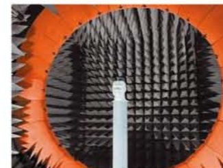
小型微波暗室 Small Microwave Anechoic Chamber
